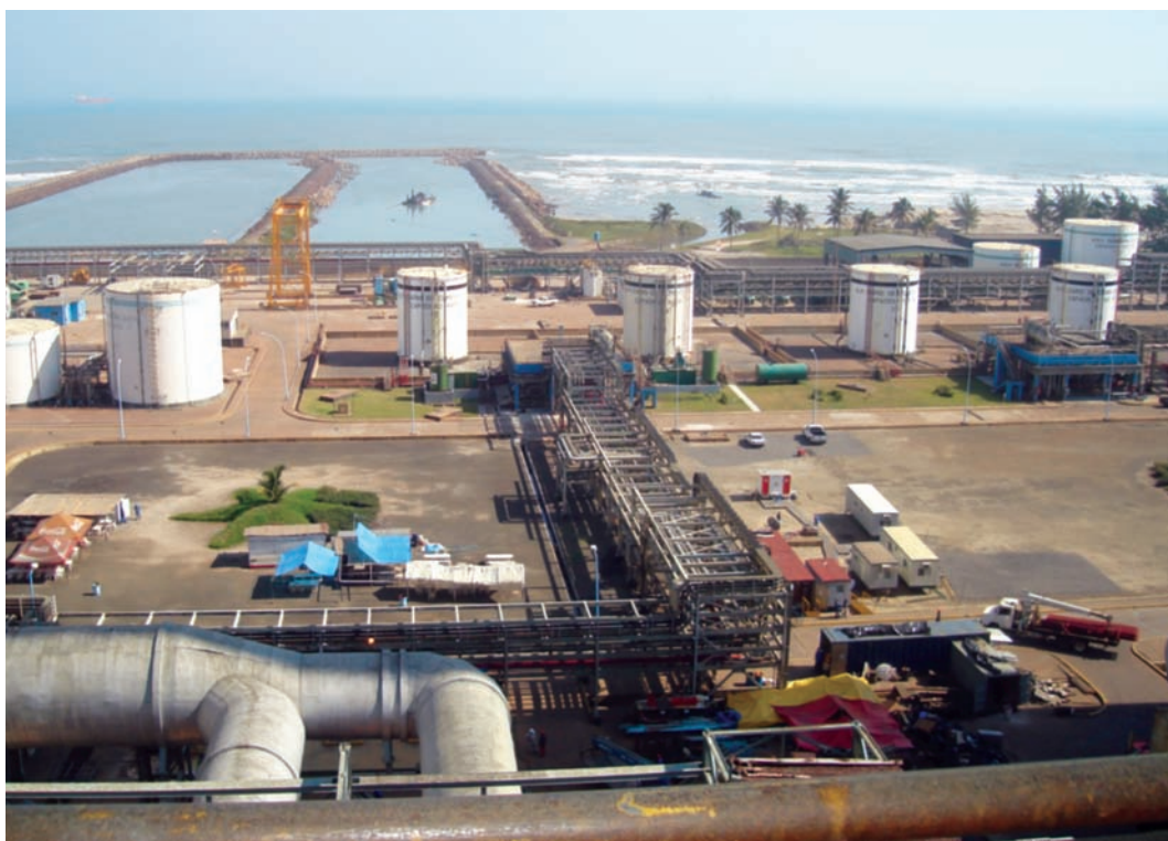
Termoeléctrica Adolfo López Mateos ubicada en Tuxpan, Veracruz
