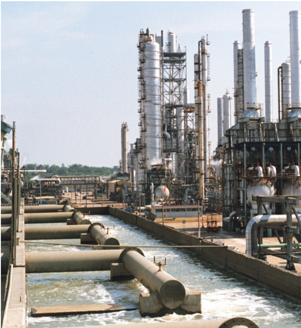
Termoeléctrica Adolfo López Mateos ubicada en Tuxpan, Veracruz
