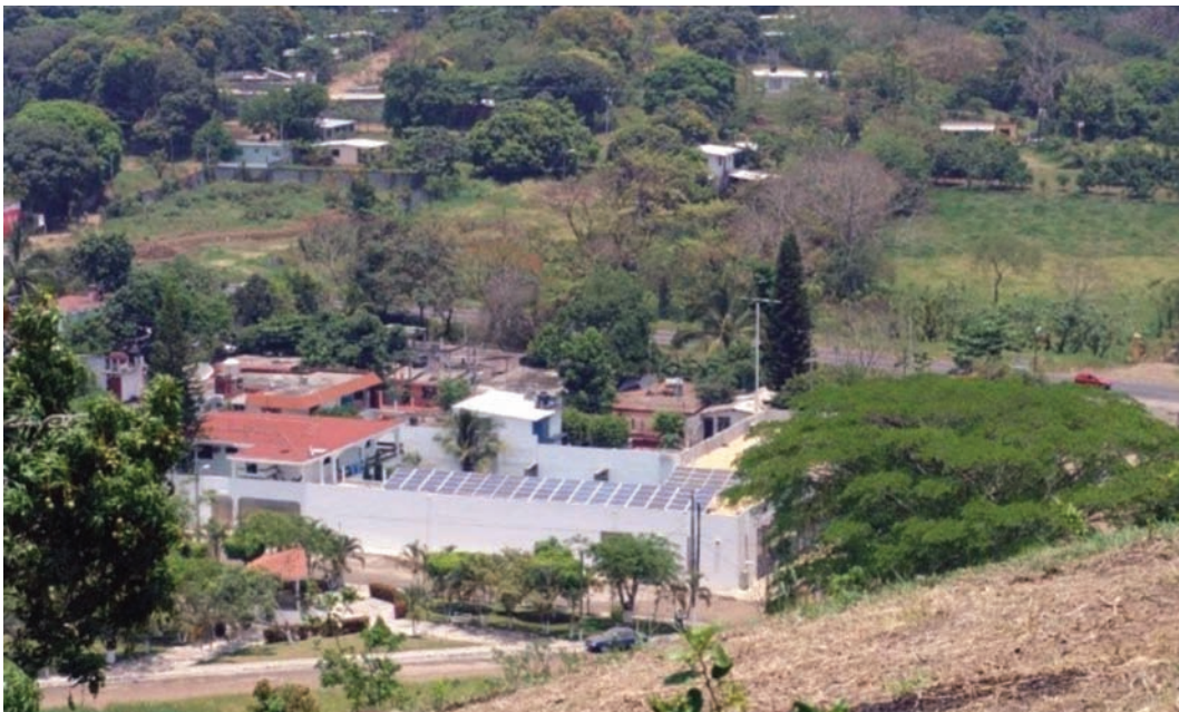
Planta Solar, Energía Renovable de México Ubicada en San Andrés Tuxtla, Veracruz
