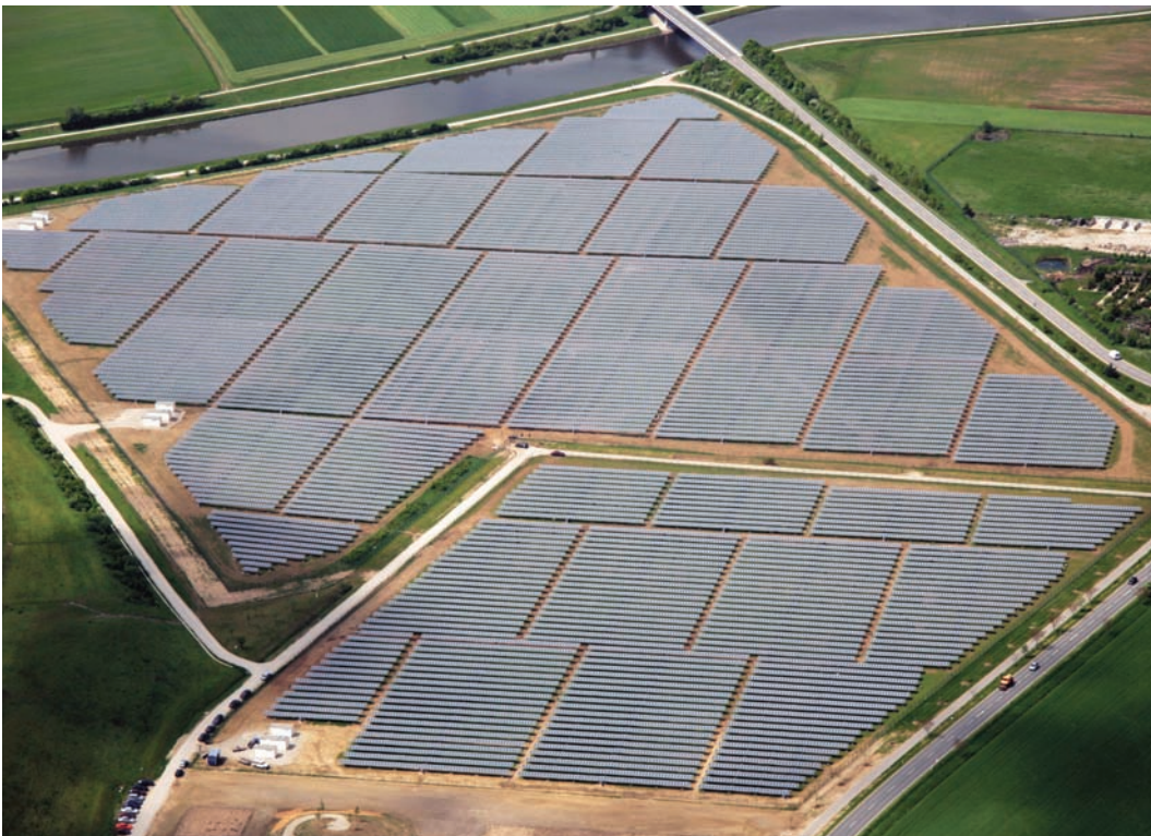
Central Fotovoltaica Solar Ubicada en Serpa, Portugal
